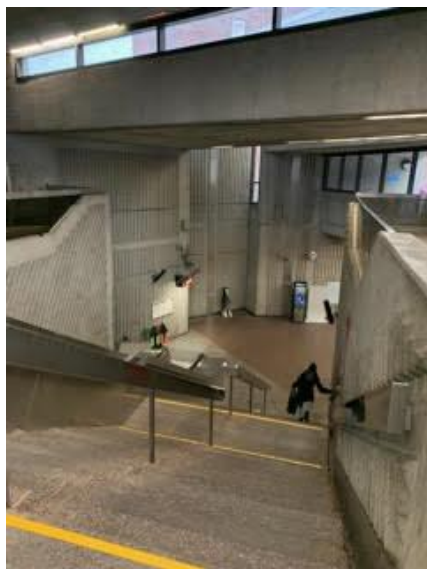
© Jérôme Saunier Description d'image Vue de l'intérieur de la station de l'Église : vue plongeante de l'escalier, marquage jaune au sol à chaque palier, murs de béton avec striures caractéristiques, étroites fenêtres horizontales, étroite fenêtre verticale.
